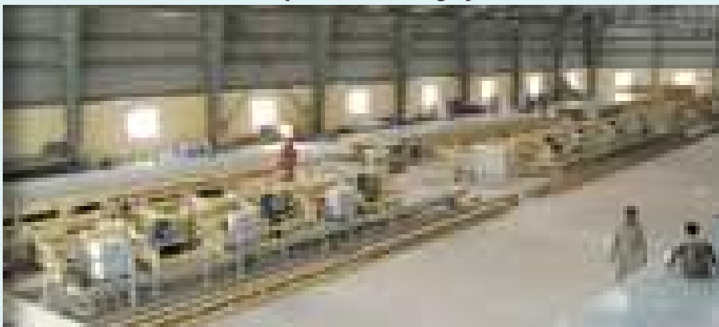
Rapidwall Plant, Mumbai.
